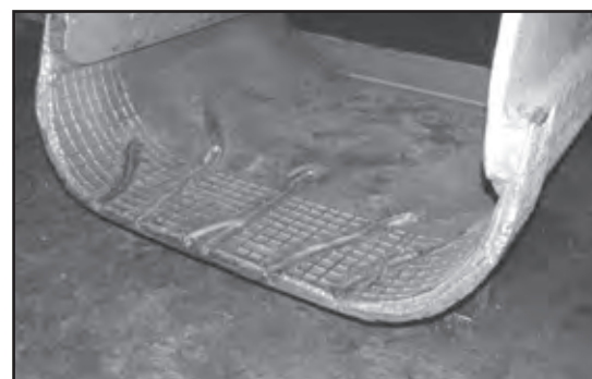
Pala preparada para soldadura de reparación con 3044-FCG.
